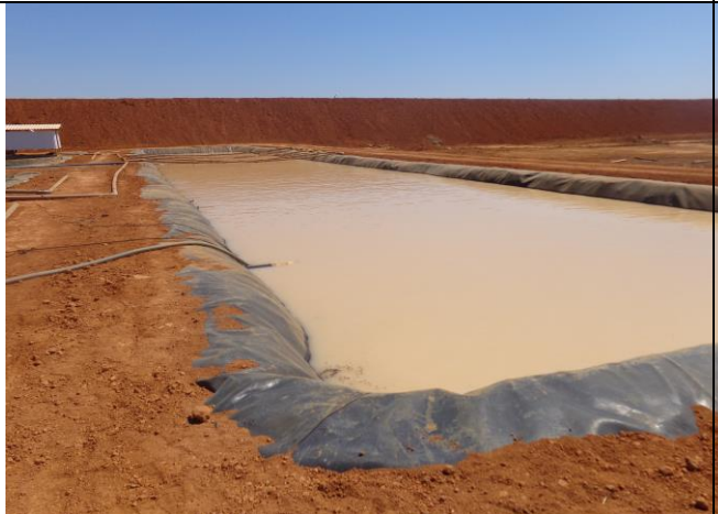
Foto 09- Lagoa de acumulação de lodo dos biodigestores
