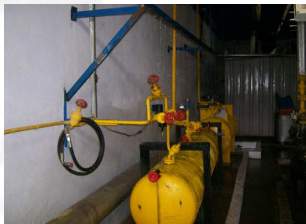
Foto 10. Tanque de armazenamento de amônia, com instalações de chuveiro e bacia de contenção. Fonte: Relatório de Informações Complementares da Consultoria.
