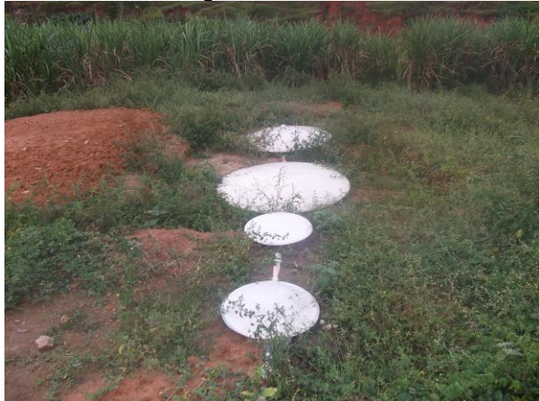
Foto 15. Sistema fossa séptica-filtro anaeróbio para tratamento do esgoto sanitário.
