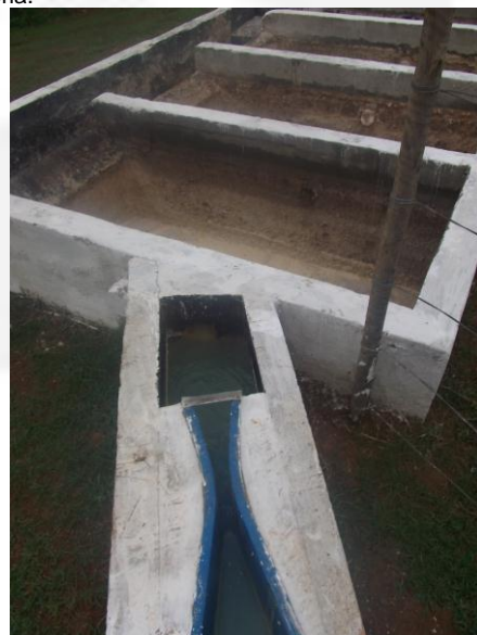
Foto 12. Medidor Parshall a jusante do desarenador, a montante com a caixa de gordura.
