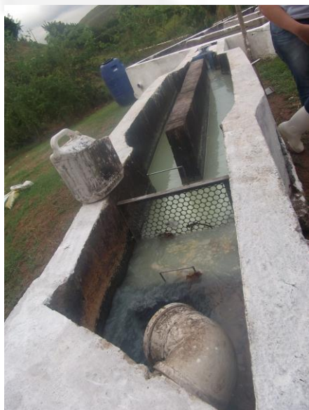
Foto 11. Vista do tratamento preliminar (peneira e desarenador).
