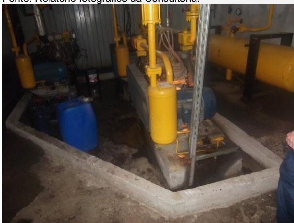
Foto 09. Sistema de produção de frio por amônia.
