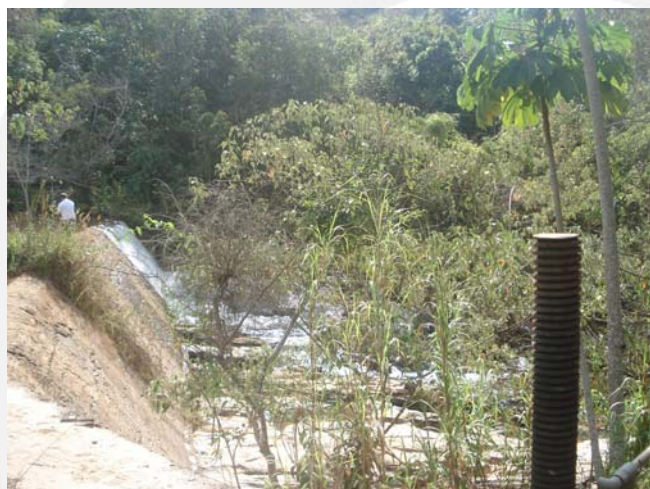
Foto 01. Vista geral da barragem.
