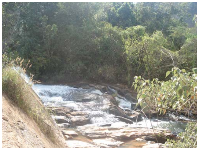
Foto 03. Trecho de vazão reduzida imediatamente à jusante da barragem.
