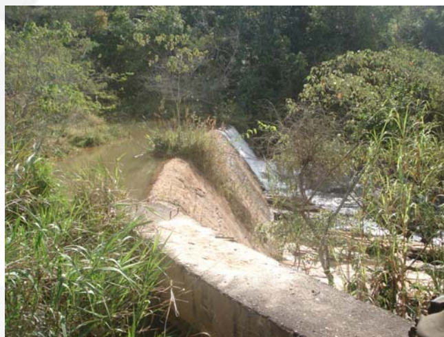
Foto 02. Vista geral da barragem, tomada d'água e canal de adução.
