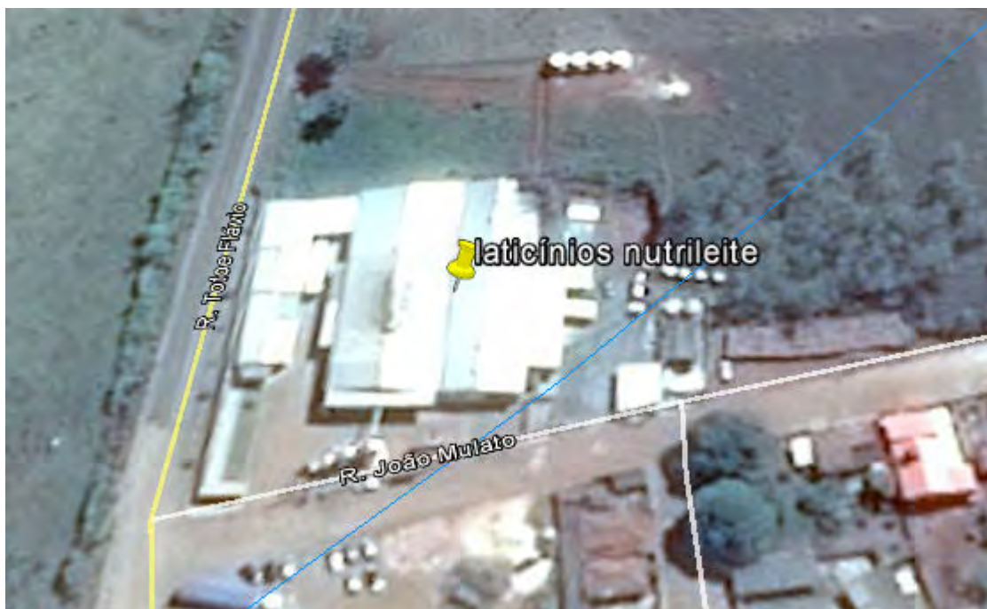
Figura 01: Vista geral do empreendimento em destaque. Fonte: Google Earth, 2016.
