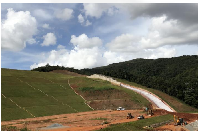
Foto 03: Maciço e Vertedouro da Barragem Itabiruçu
