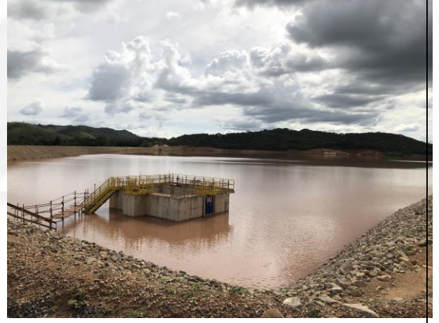
Foto 04: Extravador de Tulipa
