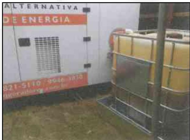
**Figura 10:** Gerador e tanque de óleo diesel com caixa de contenção.
