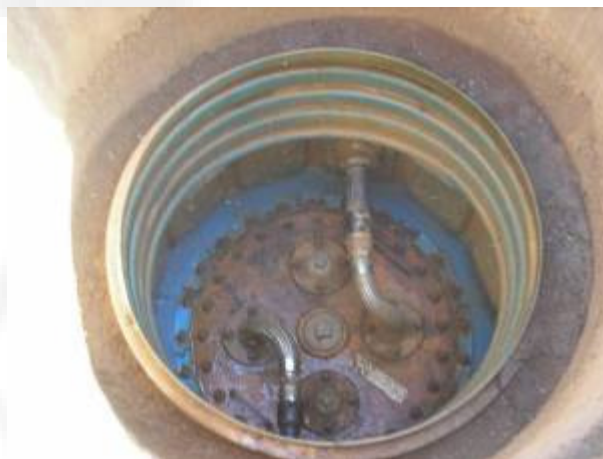
Foto 02. Sump da boca de visita do tanque.
