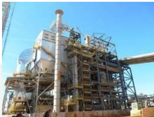
Foto 06. Local de moagem das matérias primas para fabricação do cimento.
