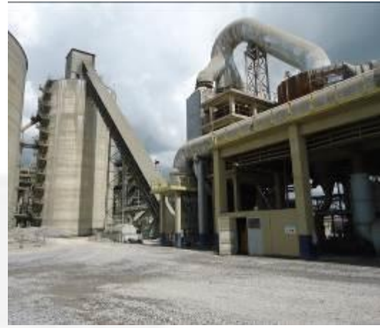
Foto 18. Resfriamento e armazenagem do clínquer.
