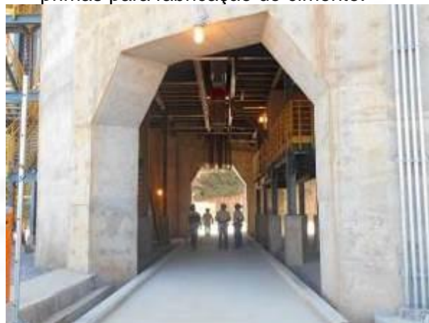
Foto 08. Local para carregamento de cimento a granel em caminhões.
