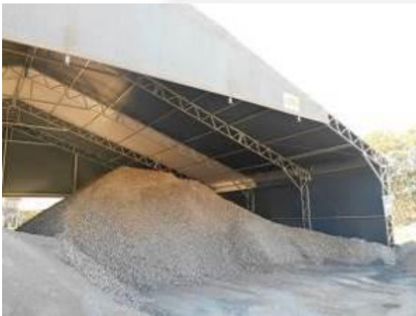
Foto 01. Galpão para armazenagem de matérias primas para fabricação de cimento.
