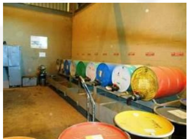
Foto 16. Local para armazenagem e manuseio de óleo.
