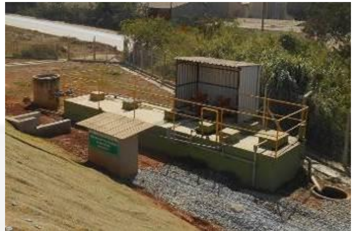
Foto 12. ETE para tratamento dos efluentes sanitários.
