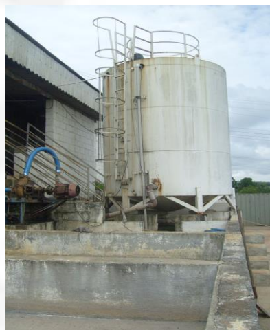
Foto 14: Tanque de tratamento químico - decantação.
