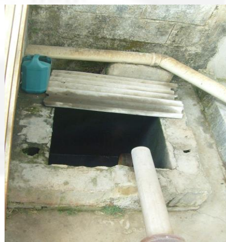
Foto 16: Efluente após tratamento encaminhado para a rede pública.
