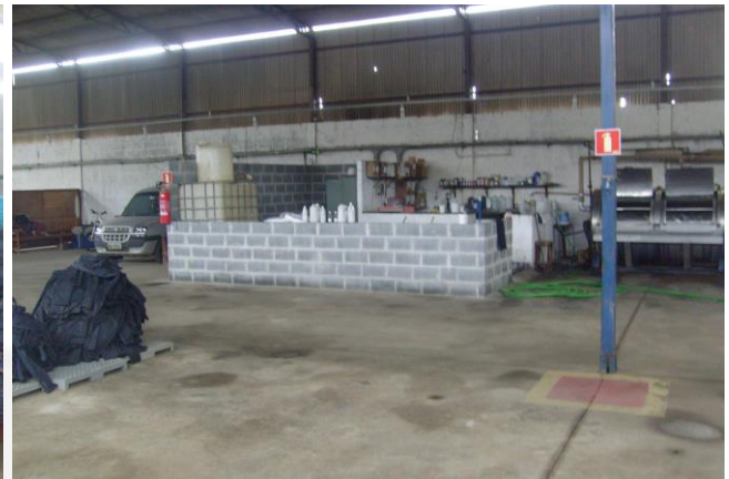
Foto 6: Depósito de insumos químicos.
