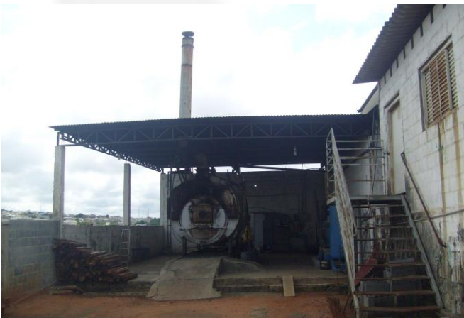
Foto 9: Área da Caldeira com a chaminé.
