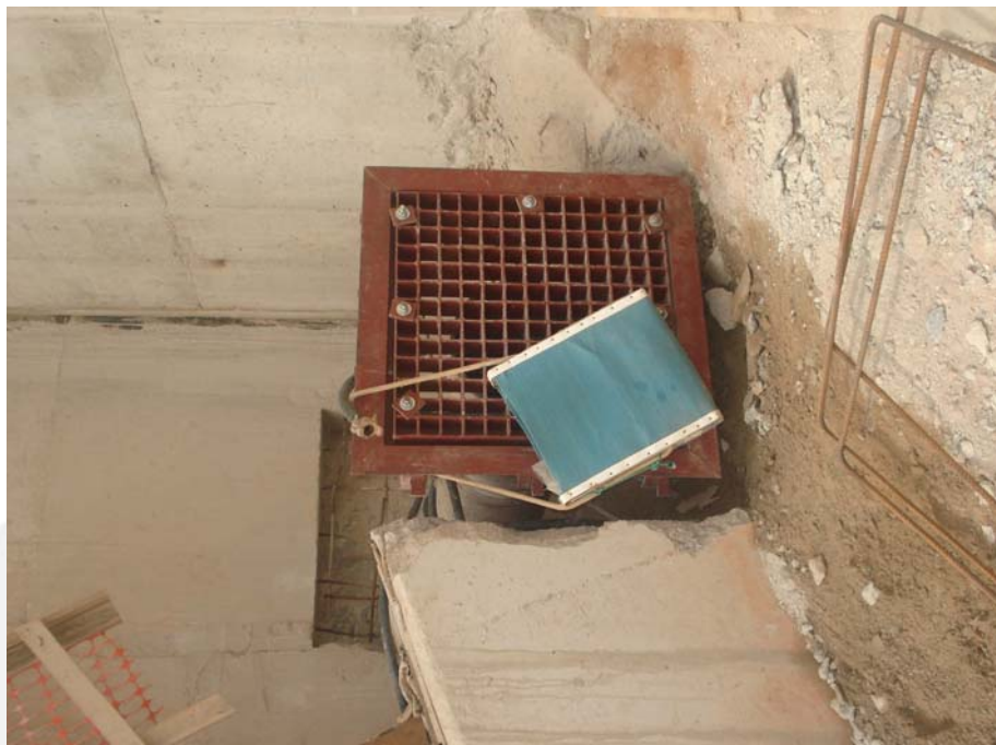
Foto 7 - Tubulação para manter uma vazão mínima no trecho de vazão reduzida.
