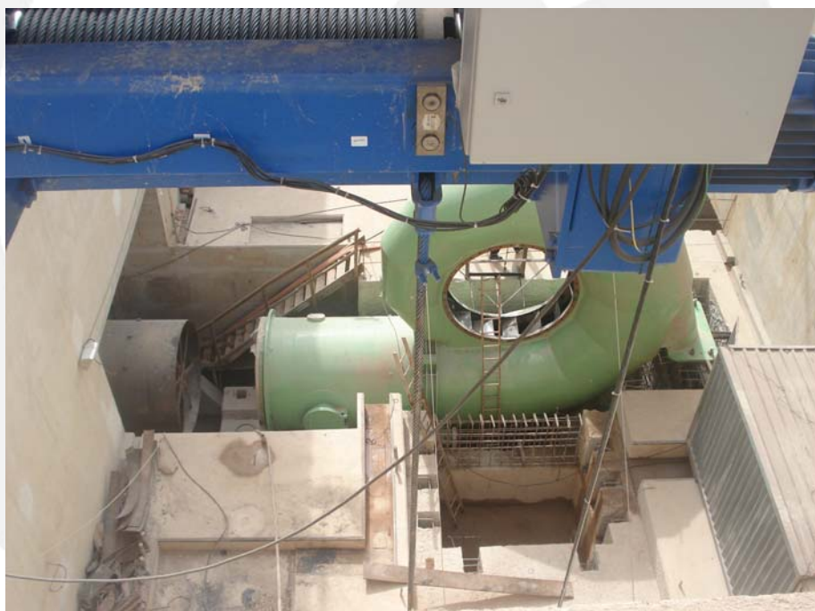
Foto 6 - Casa de Força
