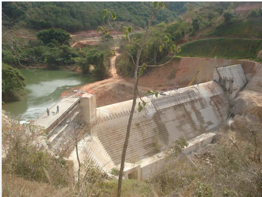
Foto 1 Barramento e Vertedouro
