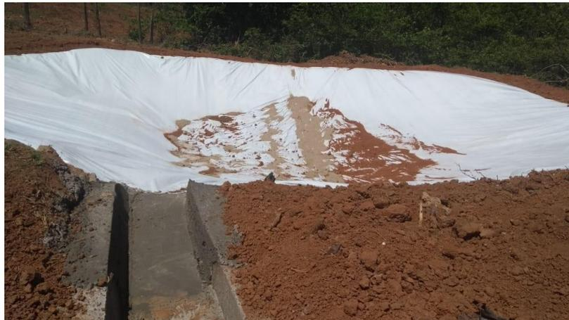
**Foto 05.** Lagoa impermeabilizada para receber água pluvial do setor de compostagem.
