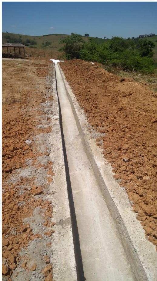
**Foto 06.** Sistema de canaletas para receber água pluvial do setor de compostagem.
