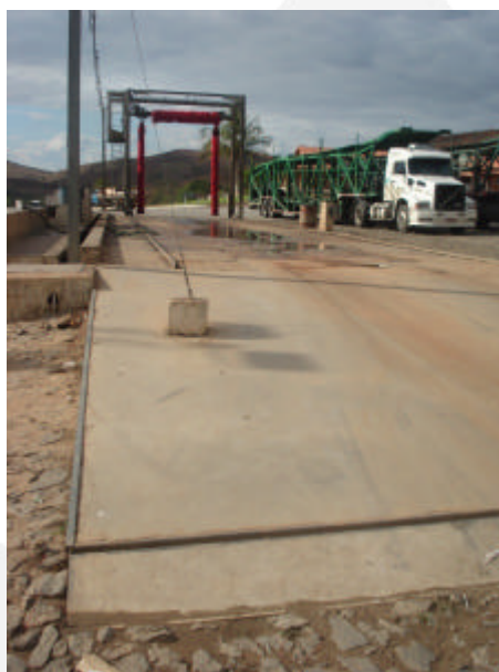
Foto 04. Lavador de veículos com piso impermeabilizado e canaletas.
