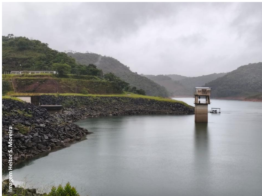
Barragem Chapéu D'Úvas – Ewbank da Câmara - MG.
