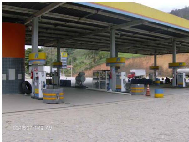
Foto 01. Visão geral do posto.
