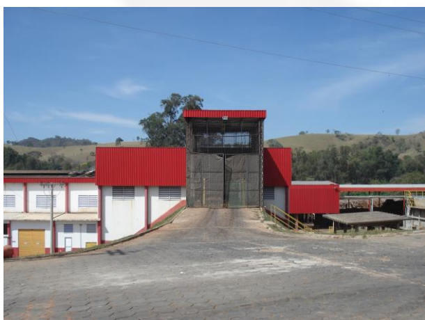
Foto 03. Vista Parcial do Empreendimento
