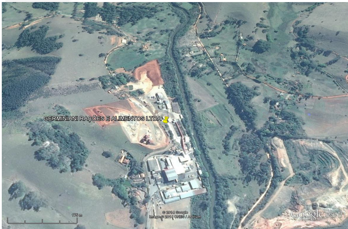
FIGURA 02 - Imagem de satélite obtida pelo Google Earth, do local onde GERMINIANI RAÇÕES E ALIMENTOS LTDA está instalada
