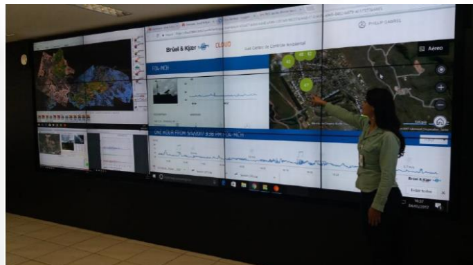
Figura. Painel de vídeo da sala de monitoramento do centro de controle da DFL (VALE). Fonte: VMA.
