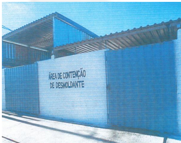
Foto 07. Local de armazenamento de desmoldantes
