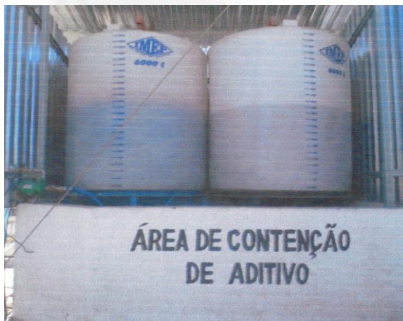
Foto 03. Local de armazenamento de aditivos
