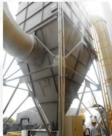
Foto 04. Filtro de mangas para tratamento dos efluentes atmosféricos.
