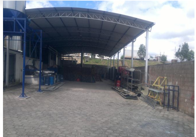
Foto 02. Pátio da empresa coberto. Neste local estão as caldeiras e são armazenados os resíduos sólidos e lenha. Destaque para o piso calçado.
