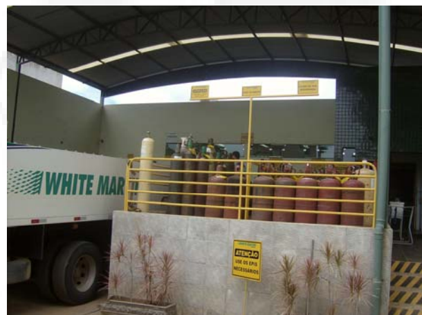
Foto 04. Área do armazenamento do empreendimento.
