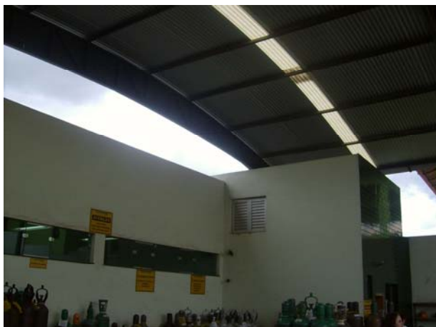
Foto 01. Área do armazenamento do empreendimento.
