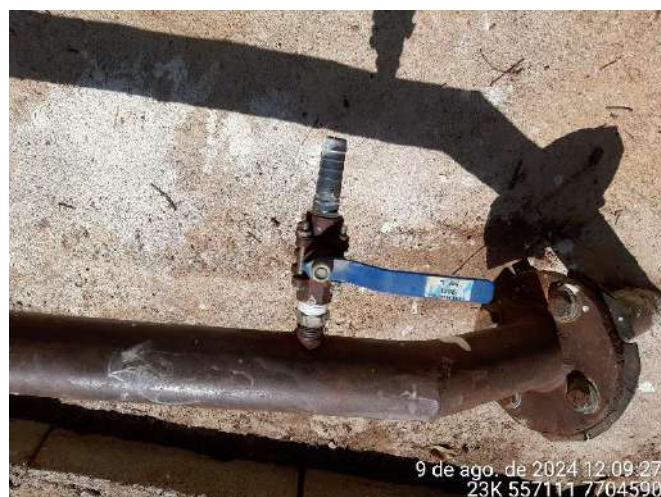
Foto 80: Torneira de monitoramento do poço 01.
