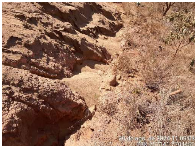
Foto 71: Porção da pilha de estéril onde pode ser evidenciado carregamento de sedimento para a vegetação vizinha. Ponto localizado nas coordenadas UTM 23K 556983 / 7704041.
