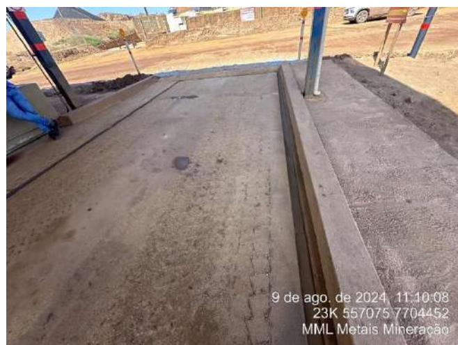
Foto 56: Pista de abastecimento com canaleta a circundando.
