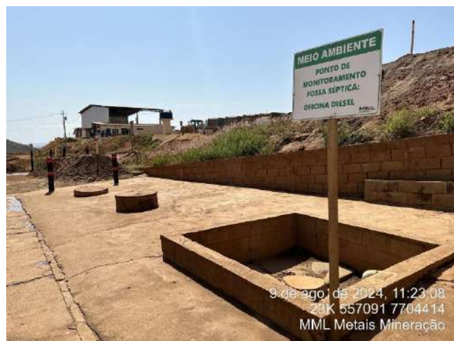
Foto 46: Fossa séptica associada à oficina mecânica e posto de combustível.
