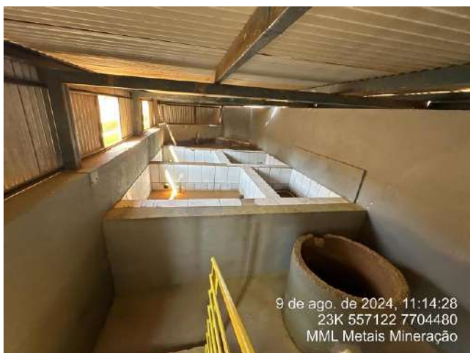
Foto 37: CSAO associada à oficina mecânica e posto de combustível.
