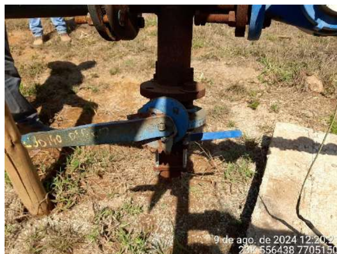
Foto 86: Torneira de monitoramento poço 02.
