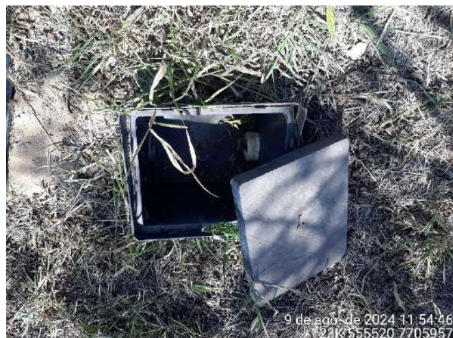
Foto 48: Saida de efluente da fossa séptica do refeitório da cava 97. Constatando que não está em uso, com compartimento seco.
