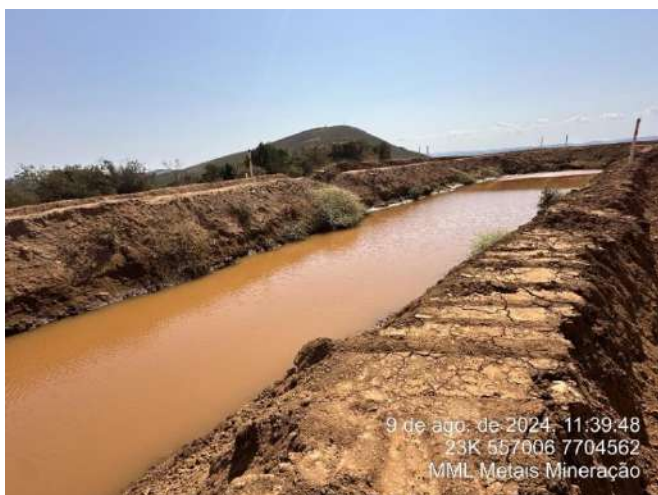
Foto 39: Tanque de acumulação de água pluvial, e efluentes advindos das CSAO.
