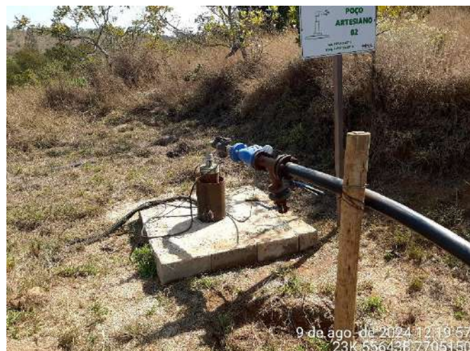
Foto 84: Poço 02 com área impermeabilizada de concreto.
