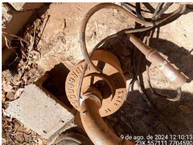
Foto 83: Poço sem o tubo de monitoramento estático.
