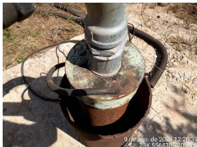
Foto 88: Poço sem o tubo de monitoramento estático.
