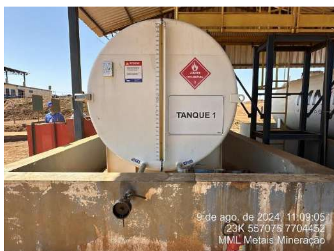
Foto 57: Tanque de combustível 01 – Diesel.
