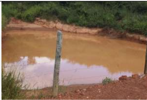
Foto 13. Acumulação de águas pluviais
