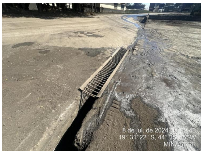
Foto 27: Canaleta de drenagem no pátio onde os lingotes são depositados, necessitando de reparo
