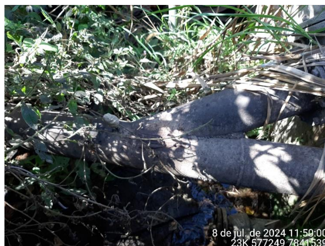
Foto 112: Ponto de reparo de vazamento da tubulação com soldagem em atendimento a IC 147724.
