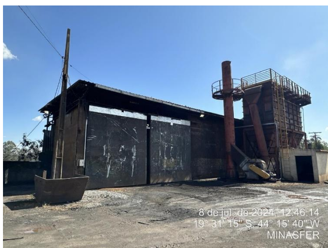
Foto 13: Galpão de carvão
