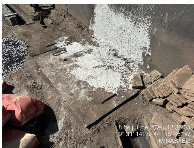
Foto 68: CSAO 03, associada à oficina industrial
