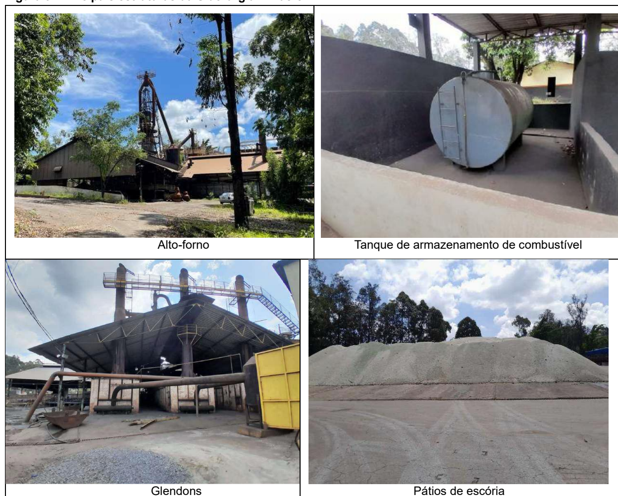
Figura 9. Principais estruturas da Siderurgia Minasfer.
