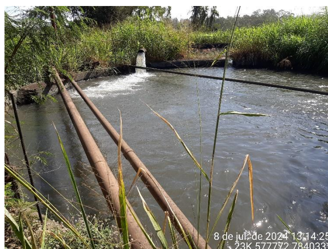
Foto 20: Tanque de armazenamento e resfriamento de água de processo recebendo água do alto-forno.
