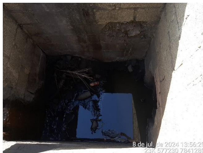
Foto 38: Caixa de passagem da tubulação subterrânea municipal que recebe o efluente da canaleta que coleta o efluente do posto e água pluvial da marginal da BR040.
