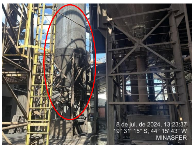
Foto 9: Lavador de gás do alto-forno 04
