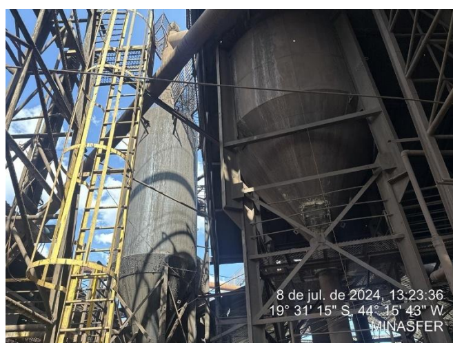
Foto 10: Balão gravimétrico do alto-forno 04, e ao lado esquerdo o lavador de gás
