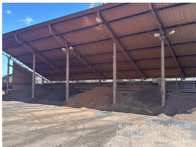
Foto 17: Silos de minério
