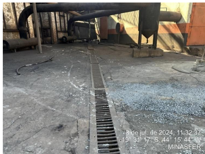
Foto 24: Canaleta de drenagem ao lado da estrutura do alto-forno 04
