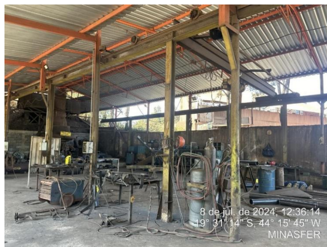
Foto 74: Oficina industrial vista internamente
