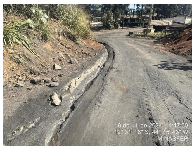
Foto 26: Canaleta de drenagem na via de acesso à bacia de decantação, necessitando de limpeza e reforma nas suas estruturas
