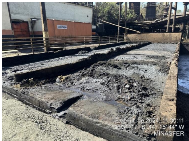
Foto 47: Tanque de pó de balão
