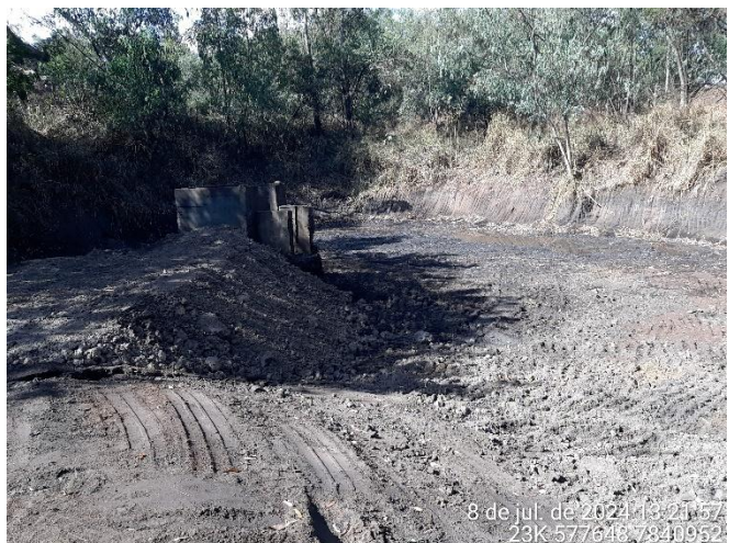
Foto 31: Bacia de decantação com indícios recentes de retirada de material.
