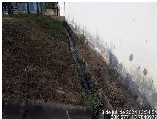
Foto 39 Canaleta que recolhe efluente do posto.
