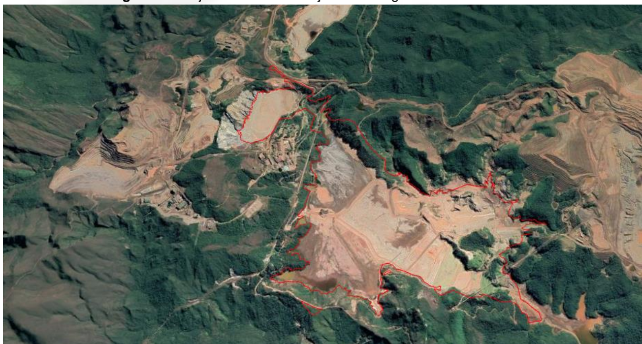
Figura 01. Projeto Descaracterização da barragem e cava de Germano
