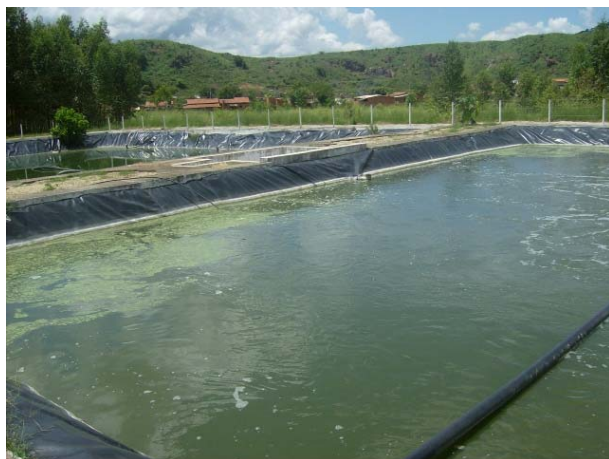
Foto 01. Lagoas de tratamento dos efluentes industriais.
