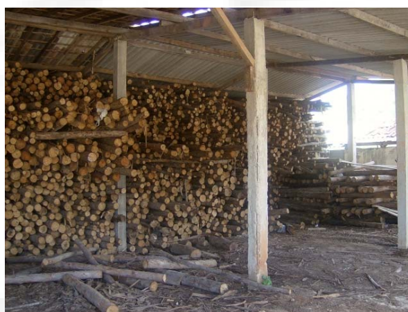
Foto 04. Galpão de armazenamento de lenha.
