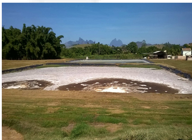
Foto 03. Lagoa para tratamento de efluentes industriais
