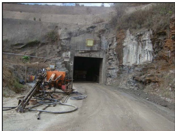
Foto 01: Entrada principal da Mina Subterrânea.
