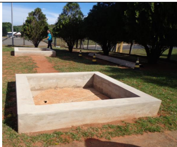
Foto 3 - Sistema de tratamento de efluente sanitário 1, após a manutenção.
