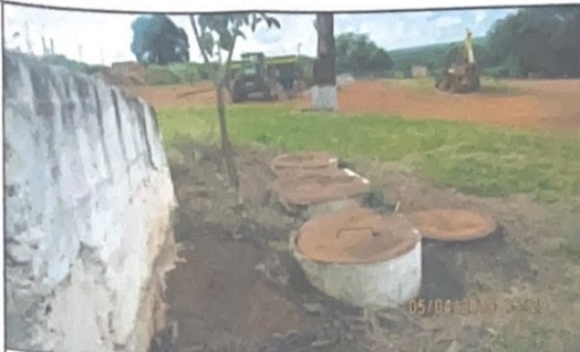
Foto 01: Caixas separadoras de água e óleo.
