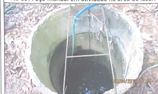
Foto 11: Cisterna utilizada na área de abate de peixes.
