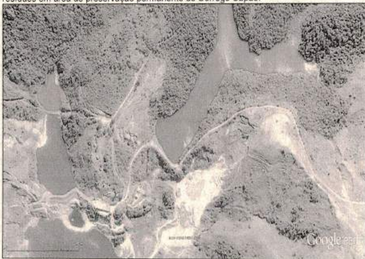
Figura 2 – Vista da Barragem de Captação I em 05/07/2013.
