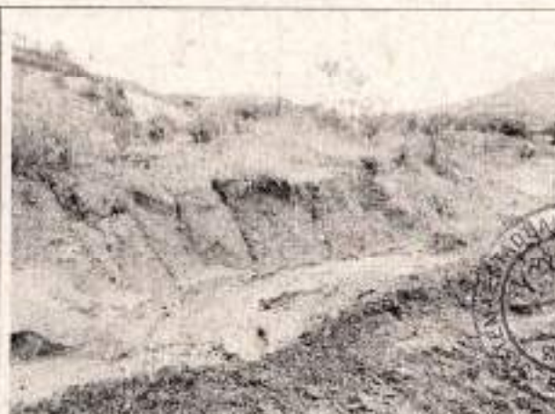
11L. Vista da área do vertedouro da "Barragem Captação II" (Fonte: Arquivo digital SUPRAM CM).
