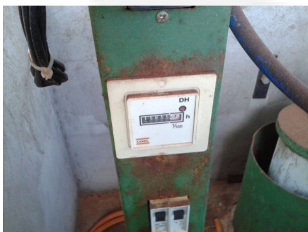
Foto 09. Horímetro do poço tubular
