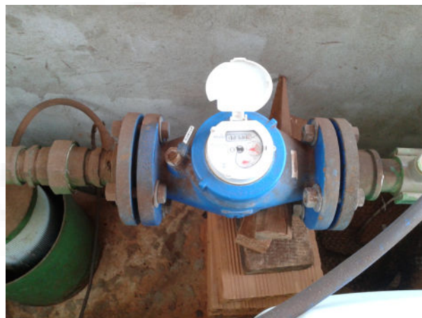
Foto 08. Poço tubular com Hidrômetro
