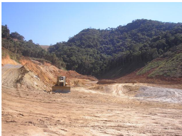
Foto 07. Depósito de estéril – enchimento da cava Bocaina.
