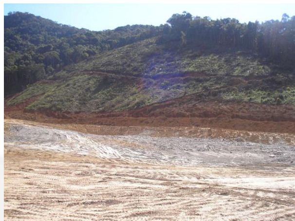
Foto 08. Depósito de estéril – enchimento da cava Bocaina.
