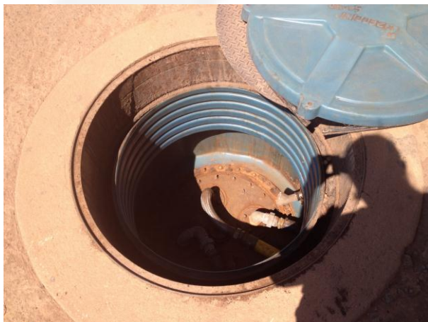
Foto 07. SUMP Tanque Combustível
