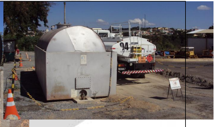
Foto 07. Posto de combustível.
