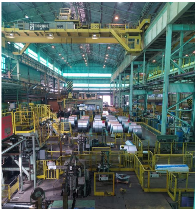
Foto 01: Visão geral do galpão das linhas de galvanização.
