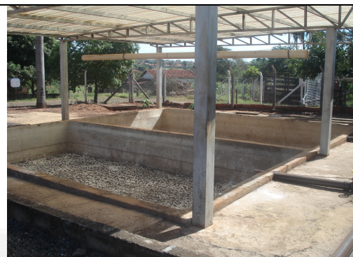
Figura 6- Leitos de secagem do lodo
