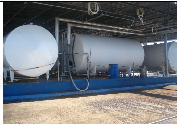
Figura 2- Tanques armazenamento leite cru
