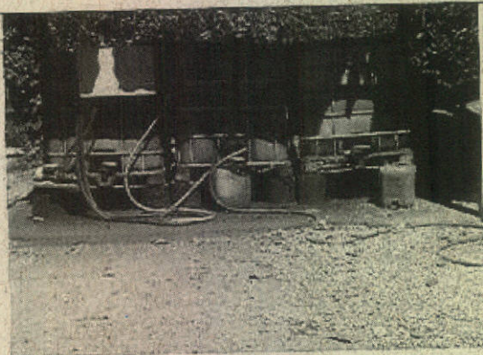
Foto 1: Local de armazenamento de óleo usado.
