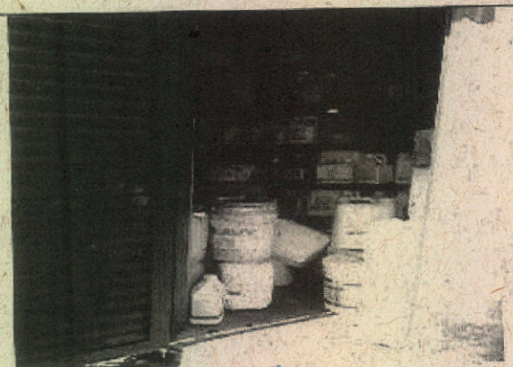
Foto 6: Local de armazenamento de agrotóxicos, sem canaletas e caixa de contenção.
