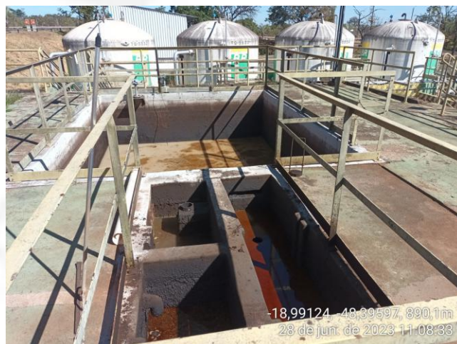
Figura 2: Sistema Caixa SAO e tanques de armazenamento do efluente tratado.
