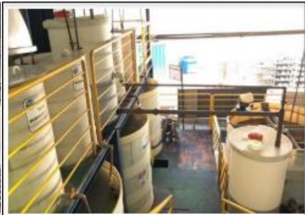
Foto 02. Vista da ETE
