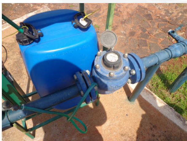
Foto 15 e 16. Poço tubular com Hidrômetro e horímetro
