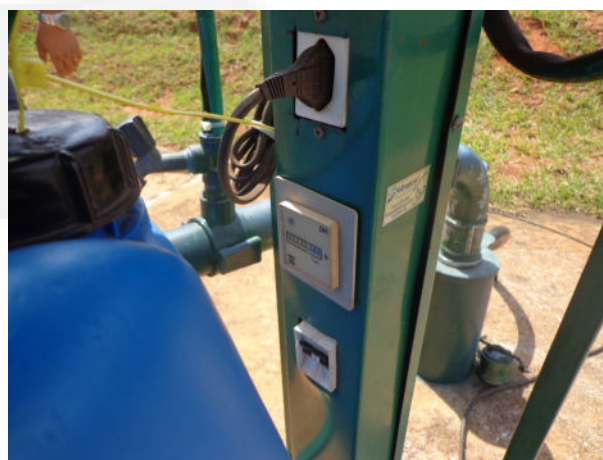
Foto 15 e 16. Poço tubular com Hidrômetro e horímetro
