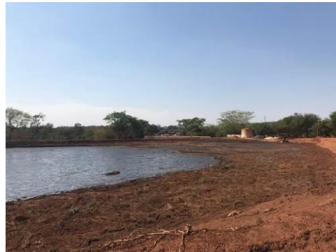
Foto 06. Reservatório de vinhaça não impermeabilizado que será desativado
