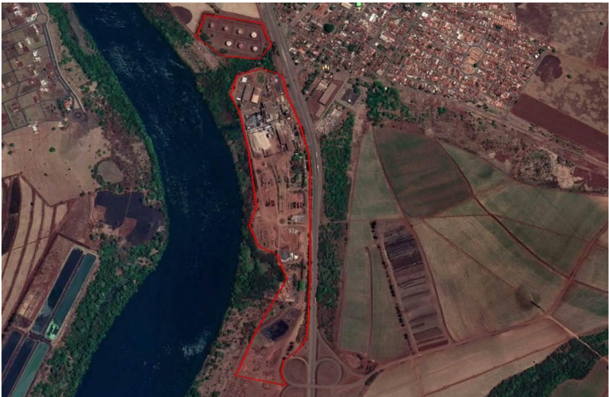
Figura1- Localização da planta industrial da Araporã Bioenergia S.A. Fonte. Google Earth (2021).
