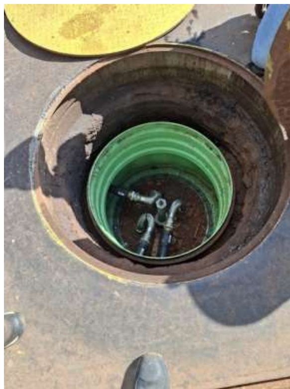
Boca de visita de tanque subterrâneo
