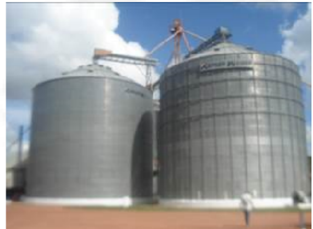
Foto 02. Silos de armazenamento
