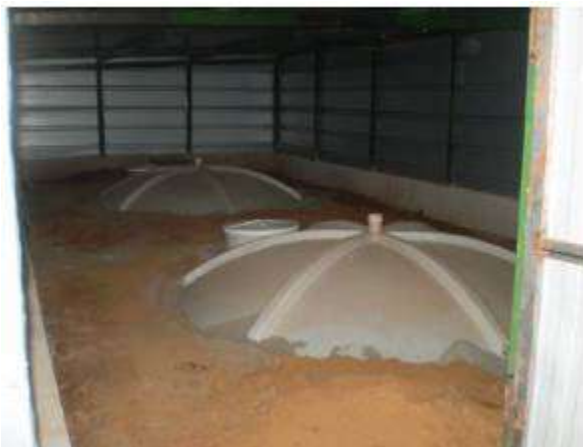
Fig.22 - Sistema de tratamento de efluentes sanitários
