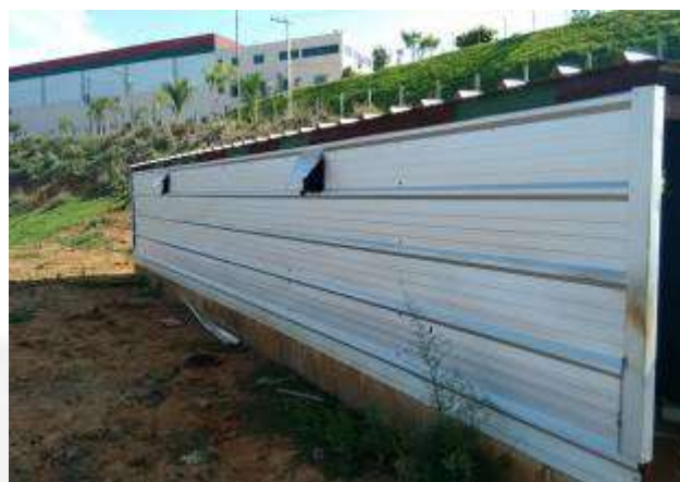
Fig. 23 - Abertura lateral para escape dos gases
