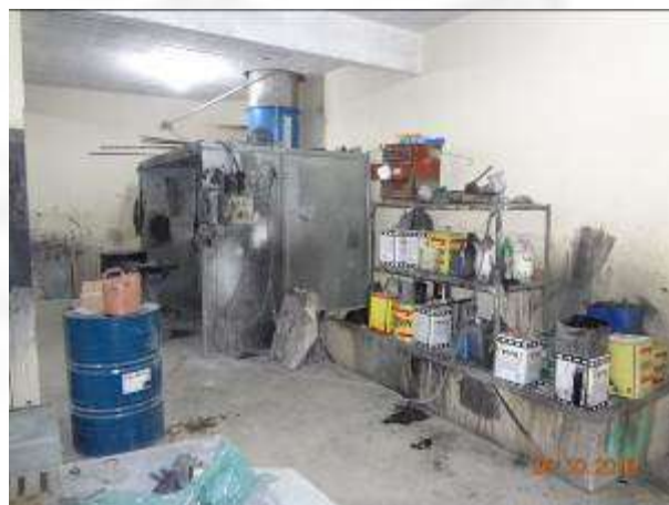
Fig. - 29 Ao lado da cabine de pintura estão dispostos os galões de tintas utilizadas no processo contidas dentro de uma bacia de contenção
