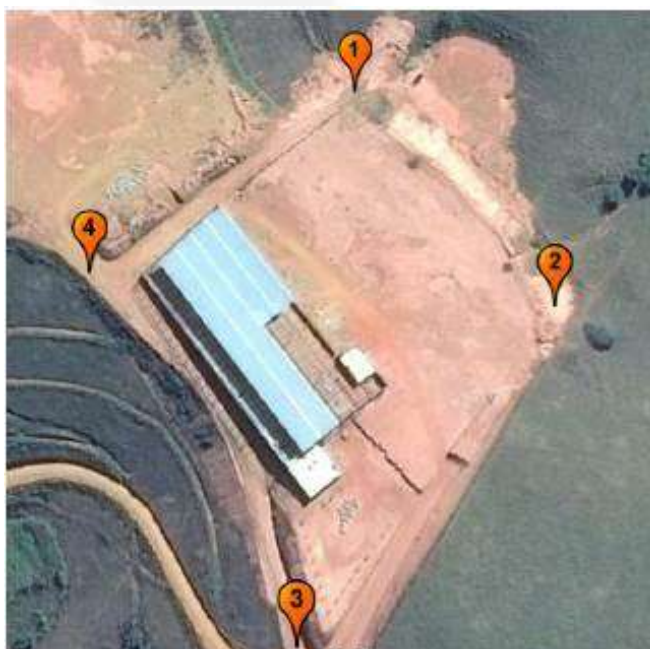
Pontos de medição do ruído
