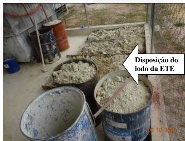
Fig. 20 - Local de disposição do lodo seco em tambores e as duas caçambas da água tratada que retorna aos tanques químicos.
