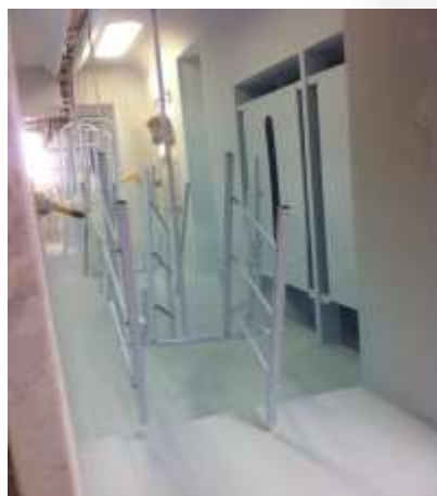
Figura 13 – Pintura eletroestática realizada no interior da cabine de pintura à seco
