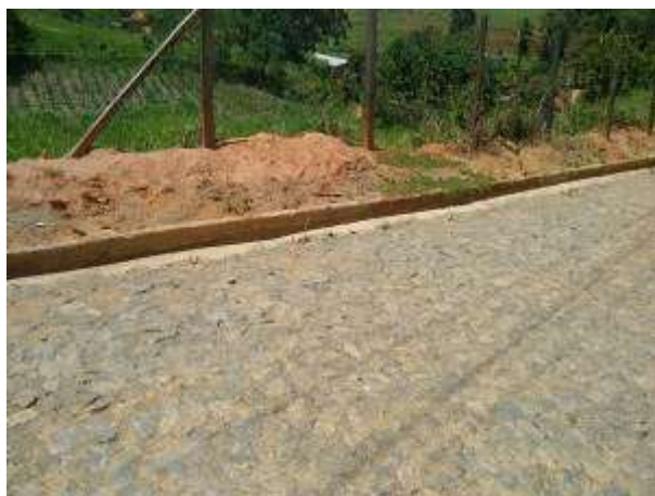
Fig. 25 - Todas as ruas de acesso a empresa foram implantadas a caneletas.
