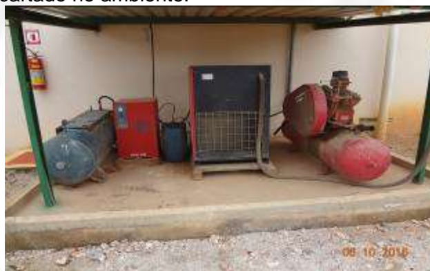
Fig. 24 - Galão inserido ao lado do compressor para a coleta da purga
