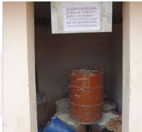
Fig. 35 e 36 - Depósitos de Resíduos Sólidos separados por baias, com cobertura, impermeabilizados e com bacia de contenção para os resíduos considerados contaminados.
