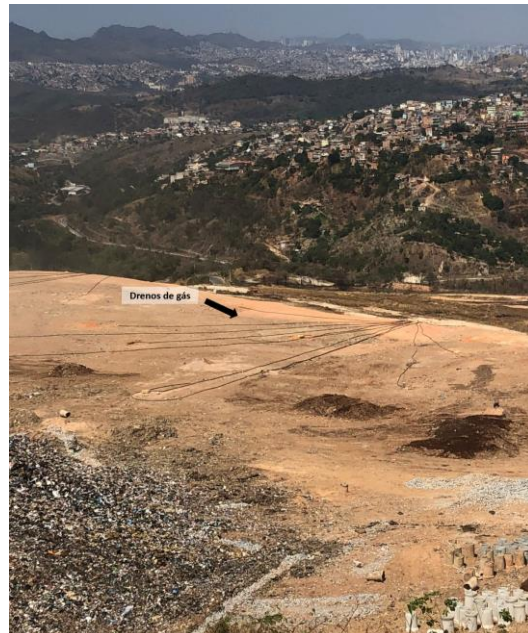
FIGURA 5 - Drenos de gás para direcionamento do metano para queima
