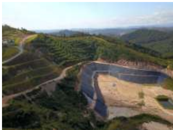
Foto 03. – Revegetação dos taludes no entorno do aterro
