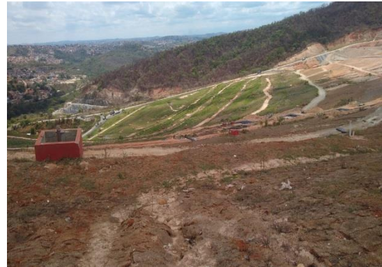
FIGURA 36 - Ponto de monitoramento geotécnico no maciço (piezômetros e marcos superficiais)
