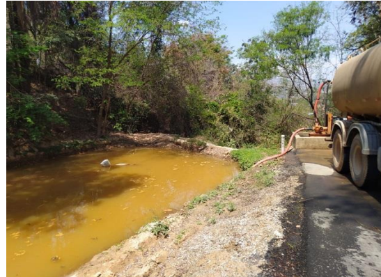
FIGURA 19 - Dique de contenção de finos- Córrego Domingos Lopes (continuação)
