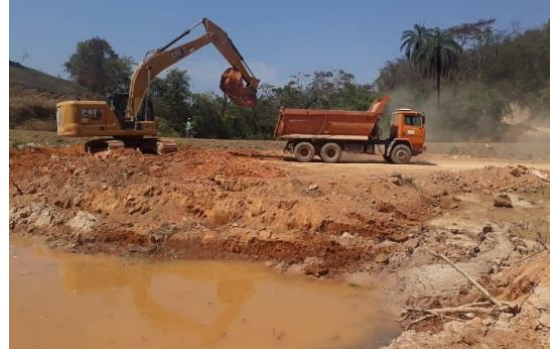
FIGURA 42 - Dique de contenção de finos – córrego Sobradinho
