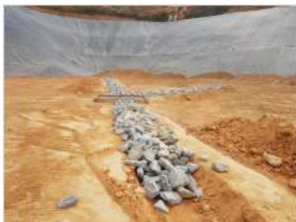
Foto 04. – Implantação da malha de drenos
