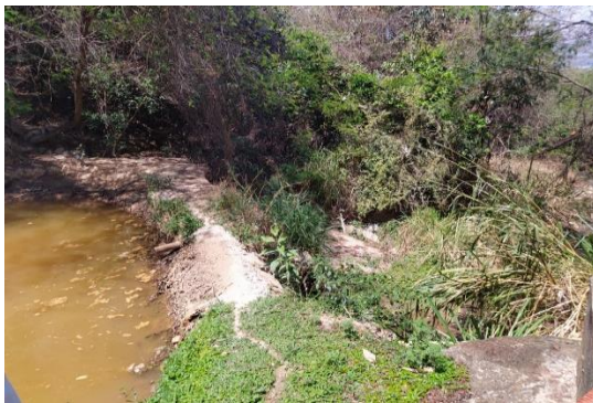
FIGURA 22 – saída do dique de contenção
