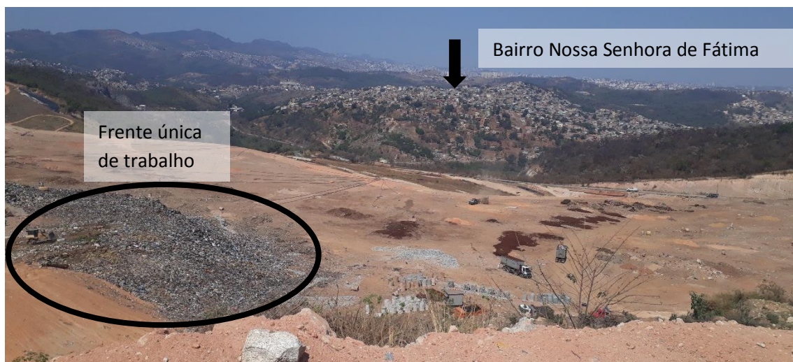
FIGURA 13 - Maciço de aterramento dos resíduos (Gleba Domingos Lopes) com visão para o bairro Nossa Senhora de Fátima
