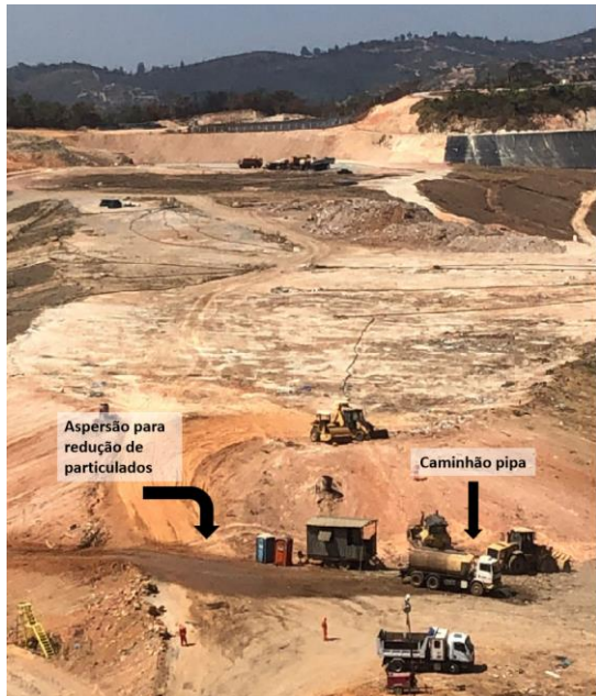
FIGURA 4 - Aspersão das áreas de tráfego de caminhões
