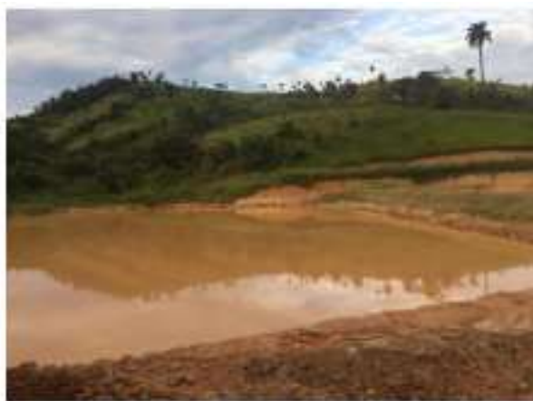
Foto 02. – Dique de contenção de finos
