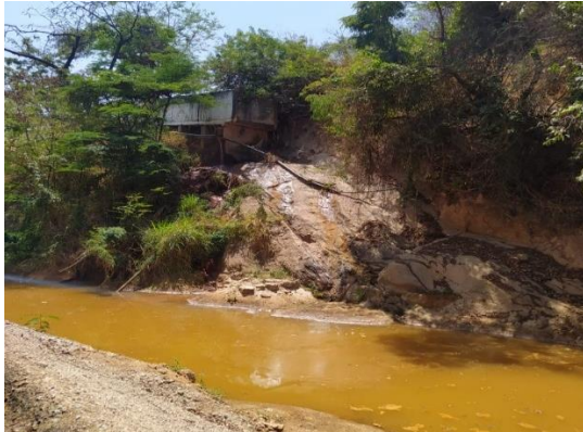
FIGURA 18 – Dique de contenção de finos- Córrego Domingos Lopes
