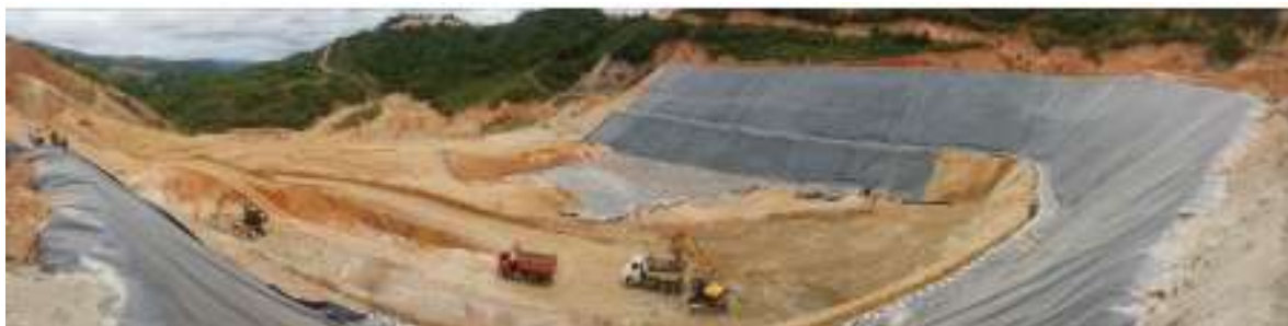
Foto 01. – Impermeabilização com manta PEAD
