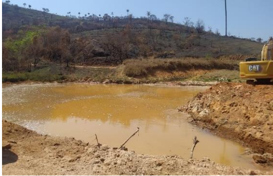
FIGURA 41 – Dique de contenção de finos – córrego Sobradinho
