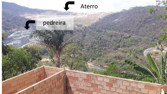
FIGURA 29 – Vista do Aterro e Rio das Velhas do bairro Nossa Senhora de Fátima
