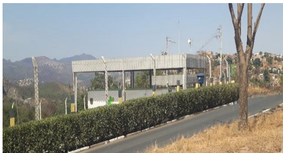
FIGURA 10 - Estação de tratamento de chorume osmose reversa
