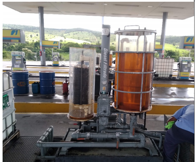
Figura 4: Pista de abastecimento.
