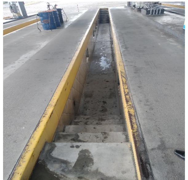
Figura 12: Vala de troca de óleo.
