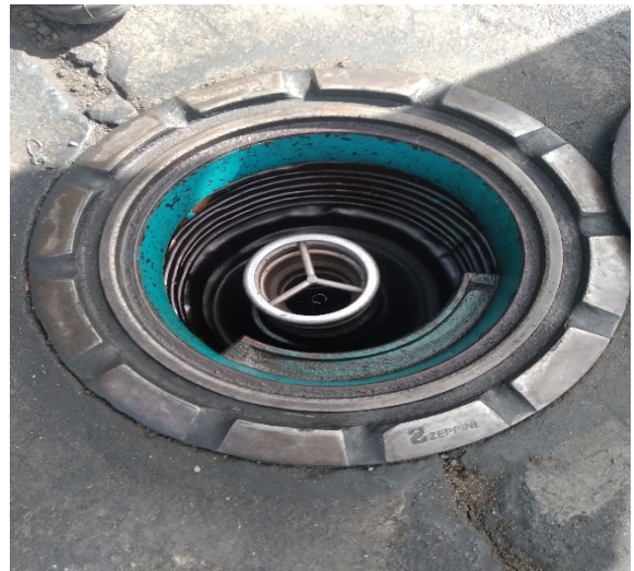
Figura 2: Bocal (anel) de vedação para descarga selada .
