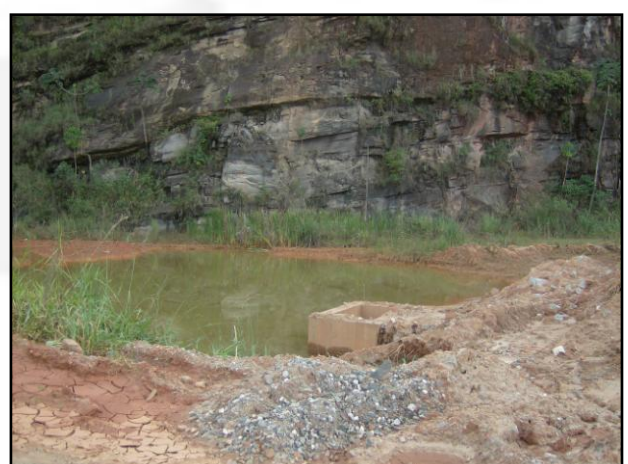
Foto 06: Dique de contenção de sólidos.
