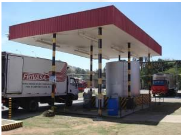
Foto 01. Área de abastecimento de veículos
