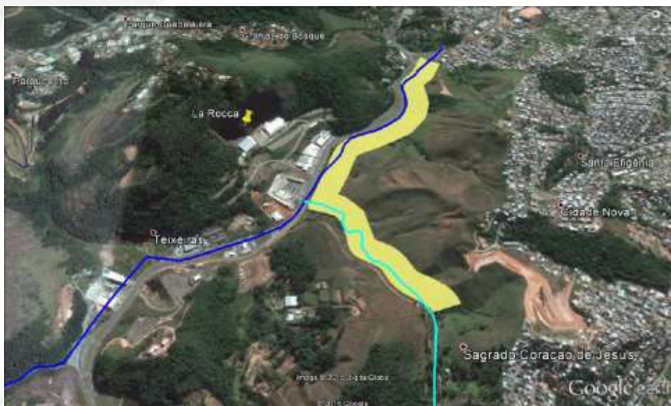
Local da canalização e seu entorno
