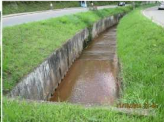
Canalização em seção aberta já existente
