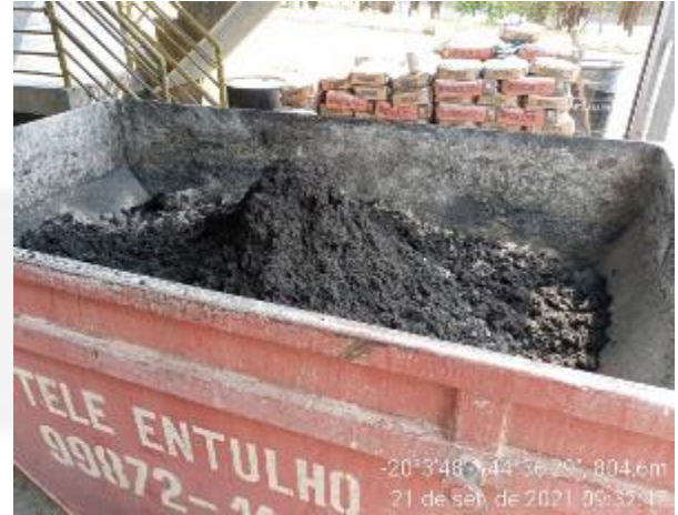
Foto 02. Separação do lodo em caçambas.
